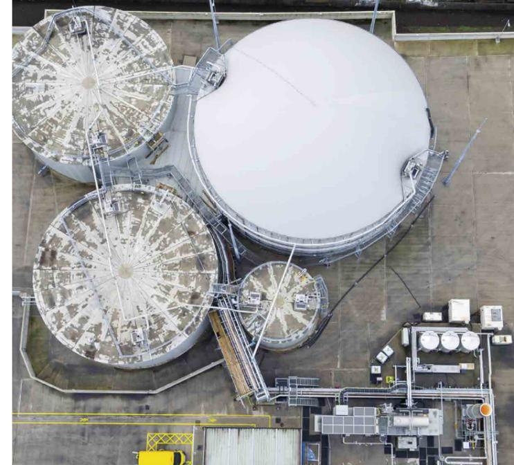
kraftwerk betrieben das 2 MW<sub>el</sub> und 2 MW<sub>th</sub> produziert und den sauberen Strom an das benachbarte Klärwerk liefert und ins allgemeine Netz einspeist. Zudem entstehen im Prozess 1.886 t/a Gärrestfeststoffe für Kompostierung (20-25% TS) und 37,611 t/a Flüssig-Gärrest für Pflanzenanbau (3-4% TS). Das sind beeindruckende Zahlen, die zeigen, was modernste Abfallaufbereitungstechnologie leisten kann.
